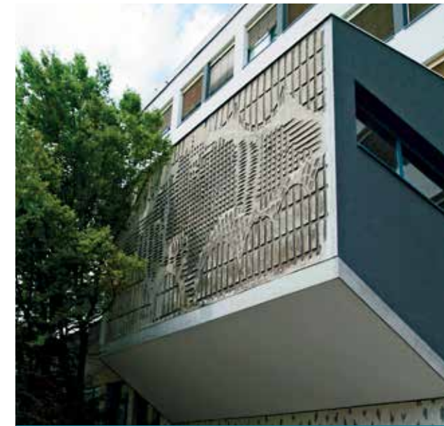
Filozofska fakulteta v Ljubljani ( arh. S. Rohrman, izgradnja 1962, energetska sanacija 2013 )
