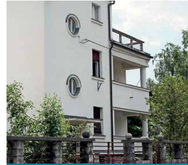
Vila Kumanovska 3 v Ljubljani ( leto izgradnje 1930, energetska sanacija 2009 )
