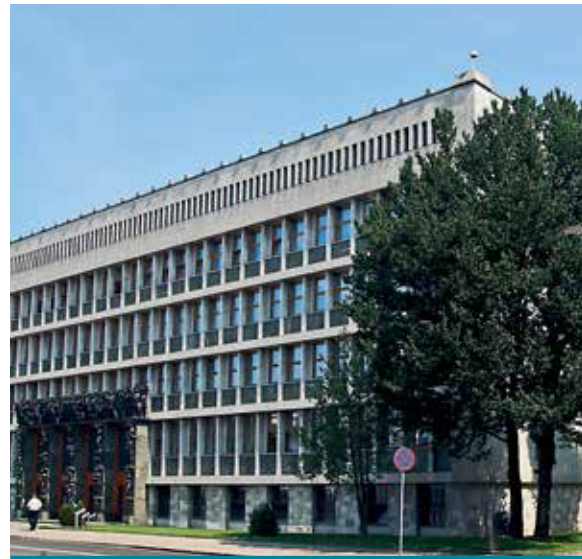
Stavba Državnega zbora v Ljubljani ( arh. V. Glanz, 1954–1959, energetska sanacija postopoma od 2004 do danes )
